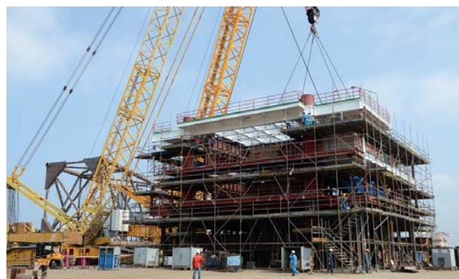
Sàn upper deck khối thượng tầng giàn đầu giếng RC9 được dựng thành công. Ảnh: PVC
